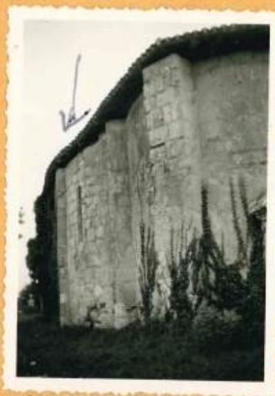
forme arrondie de l'avant chœur entre les contreforts
